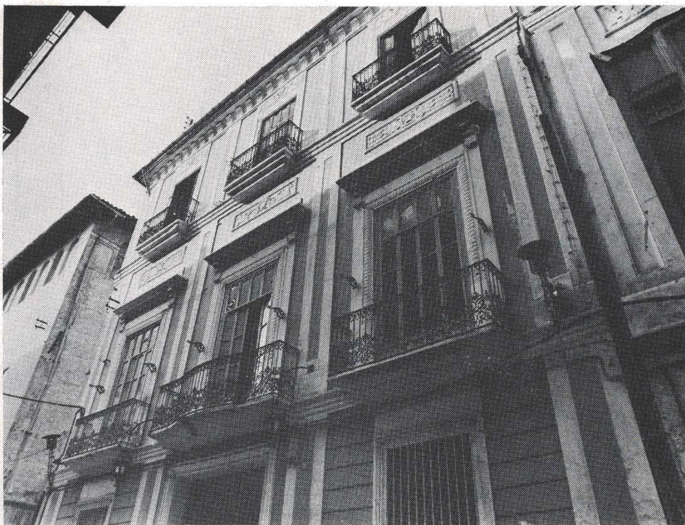
Fachada calle Moncada, 6
