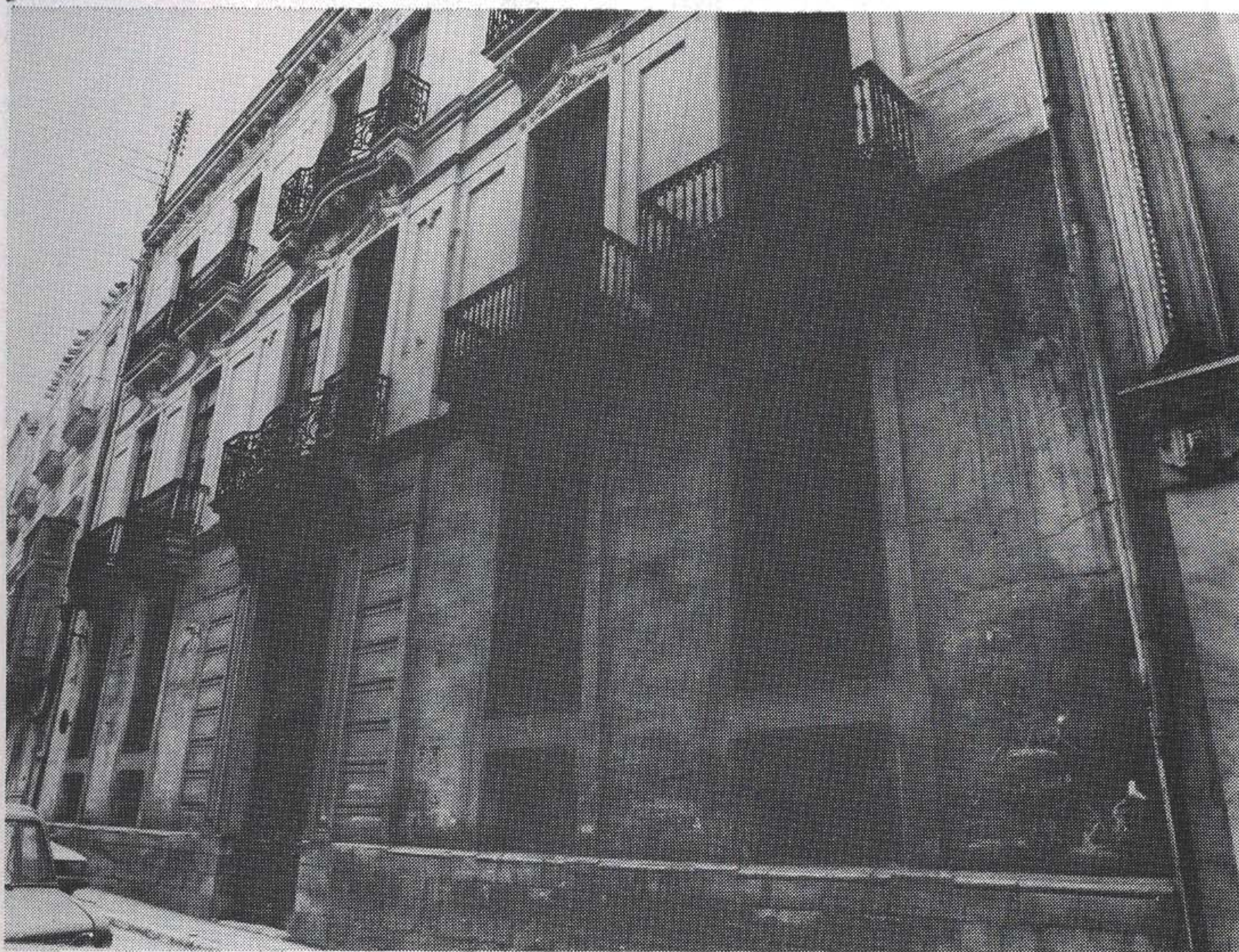
Fachada Principal calle Moncada, 13
