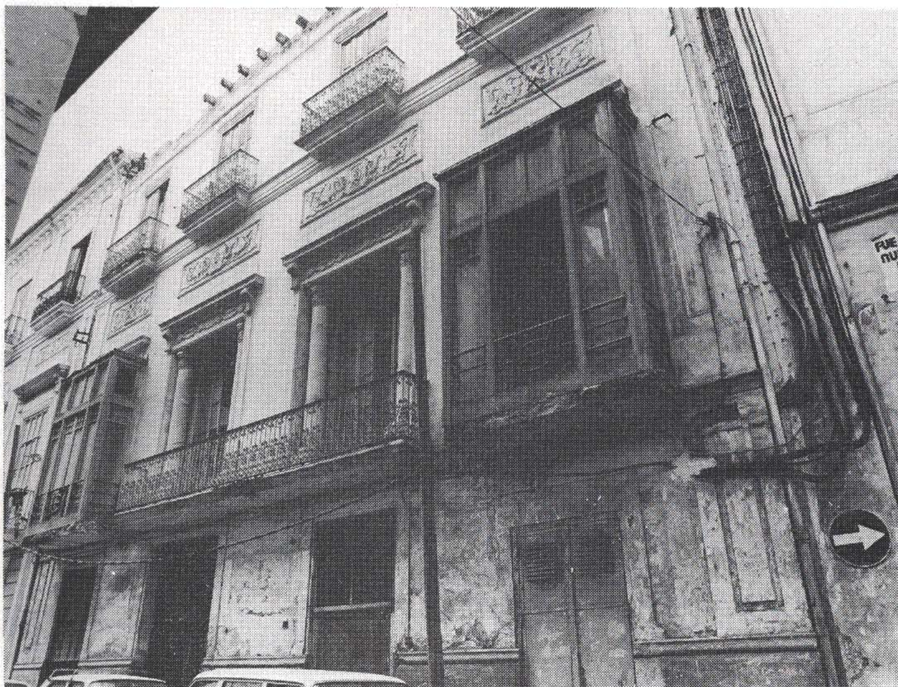
Fachada calle Moncada, 11
